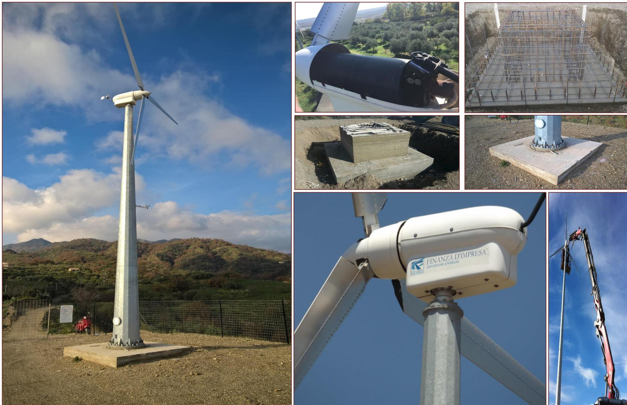
Foto 1 – Fasi di installazione Impianti Micro-Eolici (Regione Sicilia)
